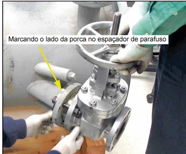
Figura 5: Montagem da válvula de isolamento
