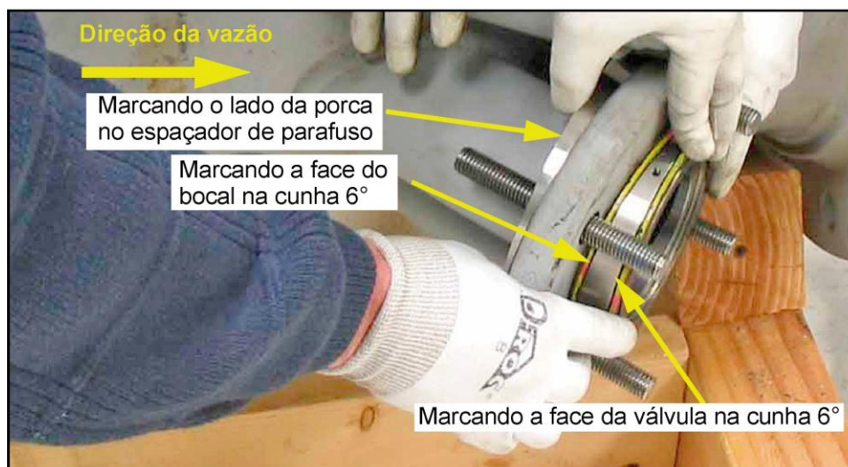
Figura 4: Posições de parafusos de montagem, espaçadores de parafuso e gaxetas
