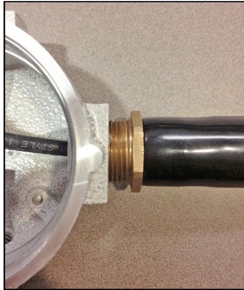
Figura 17: Aplicação de torque no prensa cabo
