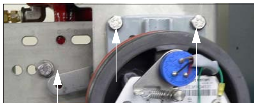
Рисунок 8. Установка RPS на монтажную пластину
