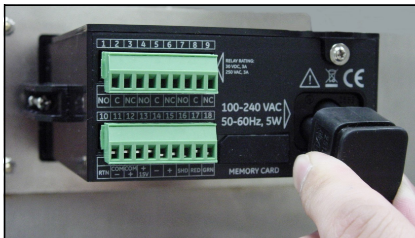
Figuur 38: De ac-stroomkabel installeren
