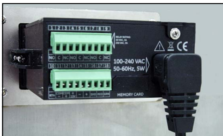
図 32 : 設置された AC 電源ケーブル
