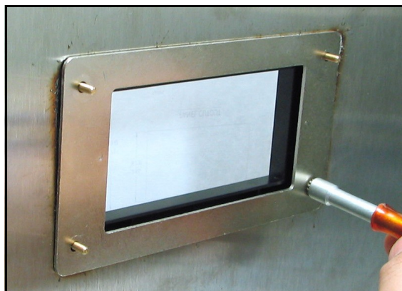
Figure 19: Fixation de l'ensemble au panneau
