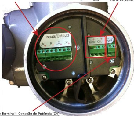
Bloco de Terminal - Conexão de Potência (CA)
