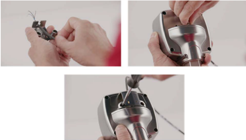
figure 4 : HygroPro II étape 1 de l'installation – câblage initial
