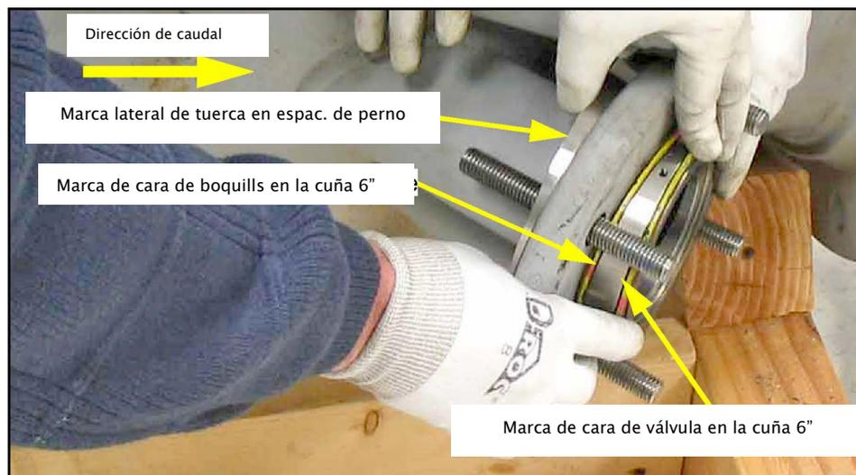
**Figura 4: Posiciones de los pernos de montaje, los separadores de pernos, la cuña y las juntas**
