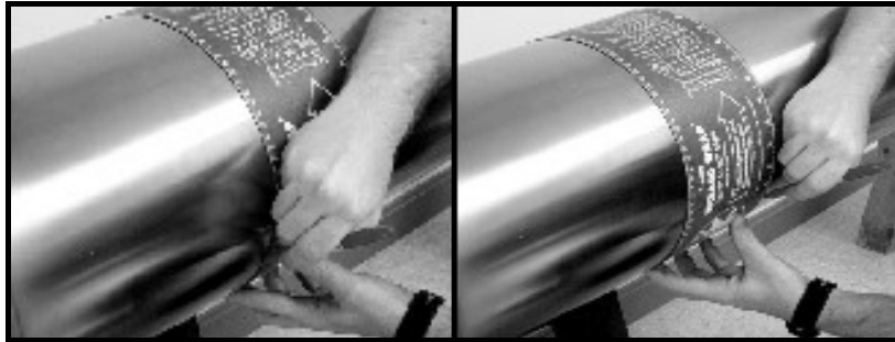
Figura 29: Marcar las líneas de circunferencia en el tubo
